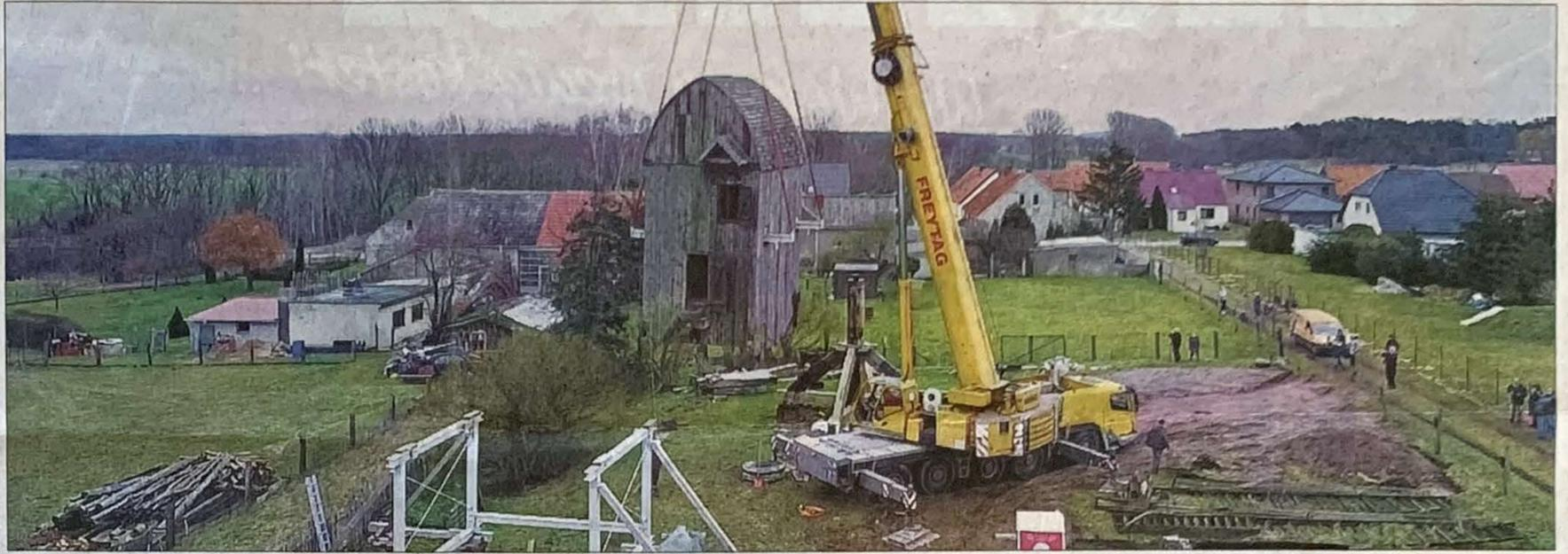
Die alte etwa 20 Tonnen schwere Holzkonstruktion schwebt am Kranhaken der Firma Freytag. Die gesamte Windmühle mit Flügeln und Inneneinrichtung wird später – nach der Schätzung des Zimmermannes Ulrich Blümner – etwa 35 Tonnen wiegen.
