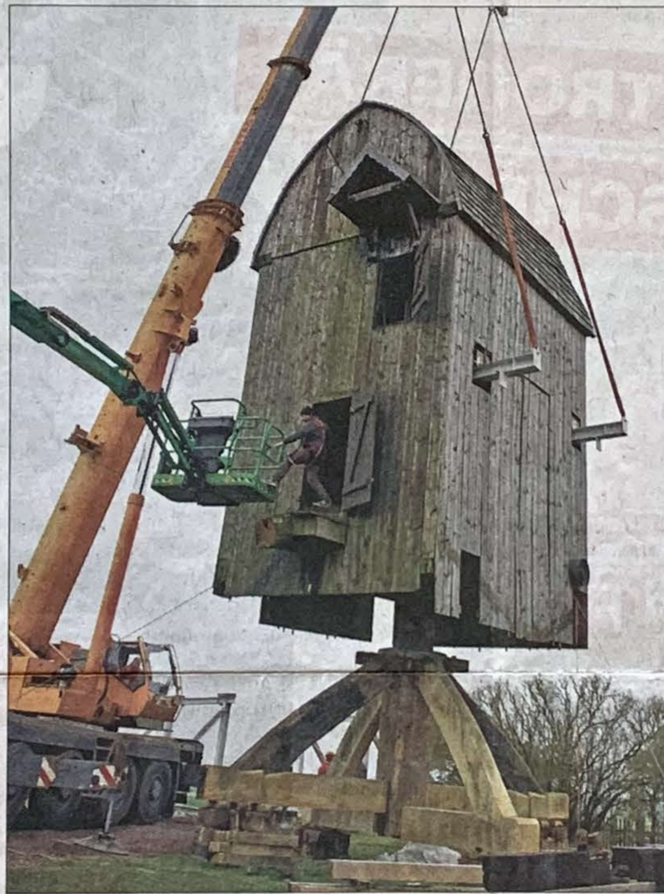
Ein Zimmermann der Firma Blümner überprüft im Inneren der Mühle, ob der Mühlenkasten genau auf dem Bock positioniert werden kann.
